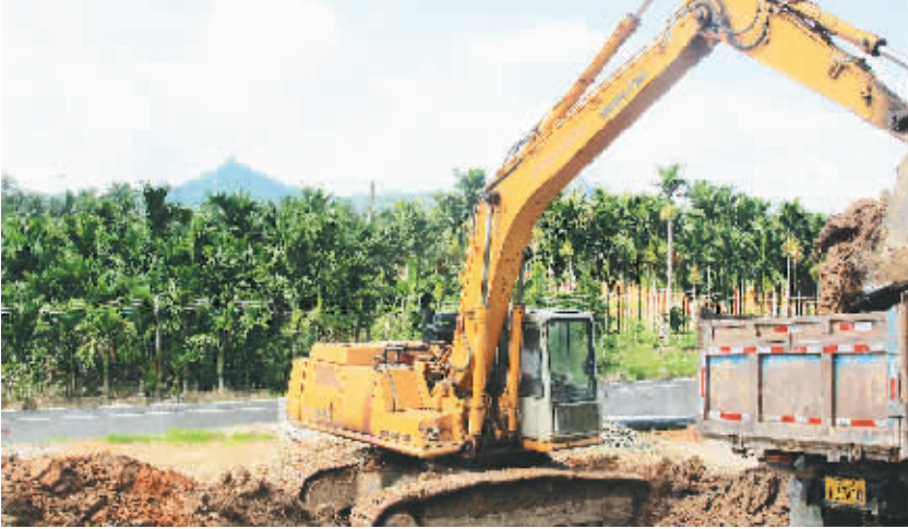
琼海白石岭旅游道路正在加紧施工。
