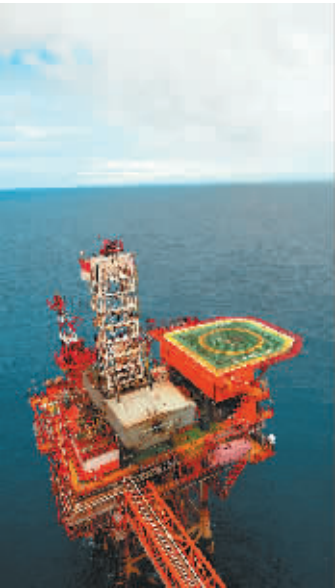
南海石油生产平台。 萌放 摄
