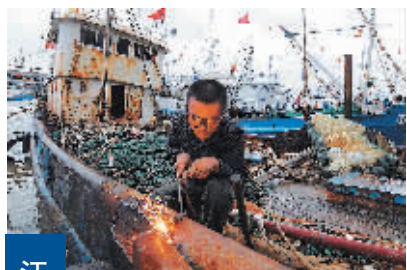
江苏 截至2日17时，江苏省已召回长江口及海上作业船只814艘，转移人员10.6万人。图为在江苏盐城射阳县黄沙港，回港避风的渔民用电焊加固渔船抵御台风。(本版图片：新华社发)
