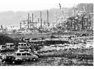
在郑州市花园口景区黄河大堤内,大型的游乐设施正在施工。新华社发
