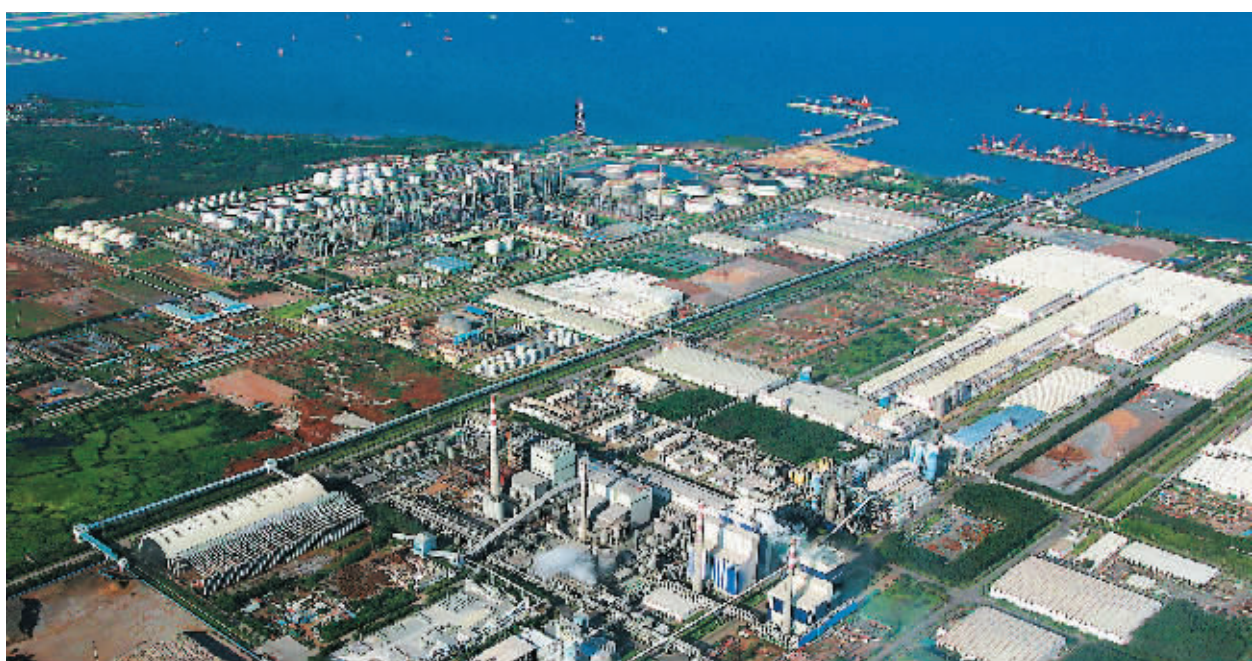
海南产业园区的翘楚——洋浦经济开发区。
