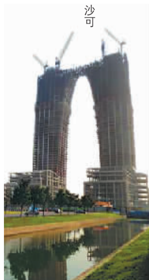
苏州正在建设中的“东方之门”。
