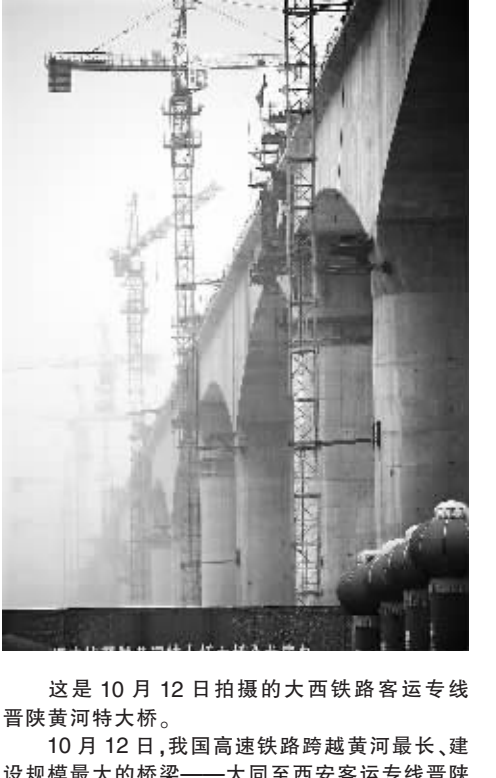
这是10月12日拍摄的大西铁路客运专线晋陕黄河特大桥。
