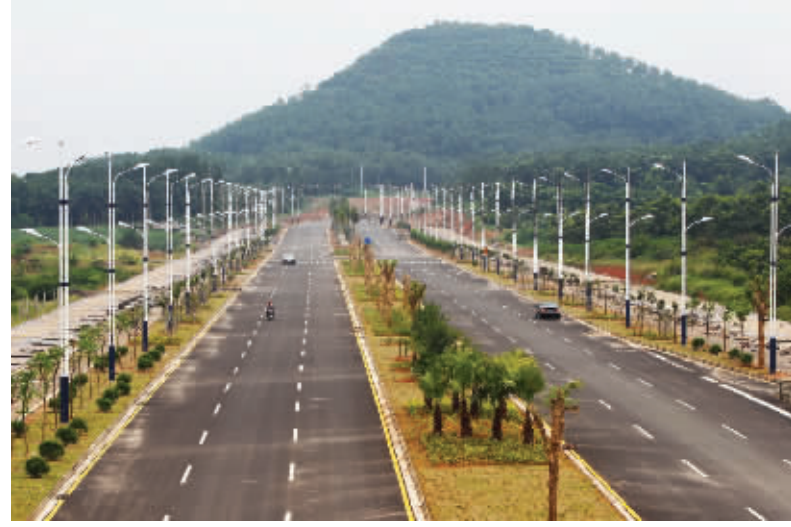
中兴大街西延线竣工通车。
