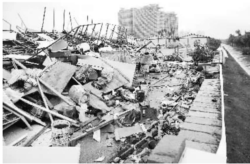
10月28日,博鳌一建筑工地遭台风刮倒的工棚。 特约记者 蒙钟德 摄
