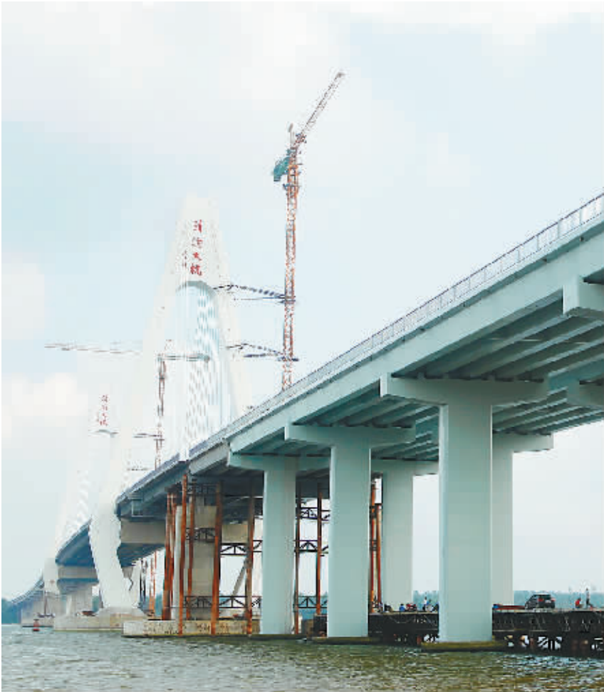
文昌清澜大桥工程收尾 11 月 4 日,工人正在文昌清澜大桥建设现场施工,大桥总体工程进入收尾阶段。清澜大桥位于文昌市东南角,横跨清澜港,全长 1828 米,主桥长度 548 米,宽度 34 米,为双塔双索面结合梁斜拉桥。 本报记者 苏晓杰 摄
