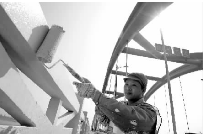
3月2日上午,公路局工作人员忙着粉刷、清洗海口琼州大桥。该桥将以全新的面貌迎接建省办经济特区20周年。 本报记者 张杰 摄
