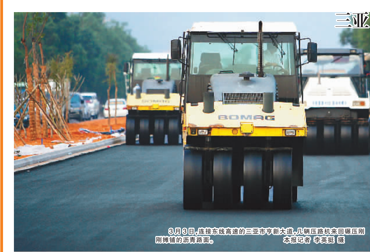
3月3日，连接东线高速的三亚市亨新大道，几辆压路机来回碾压刚刚摊铺的沥青路面。
