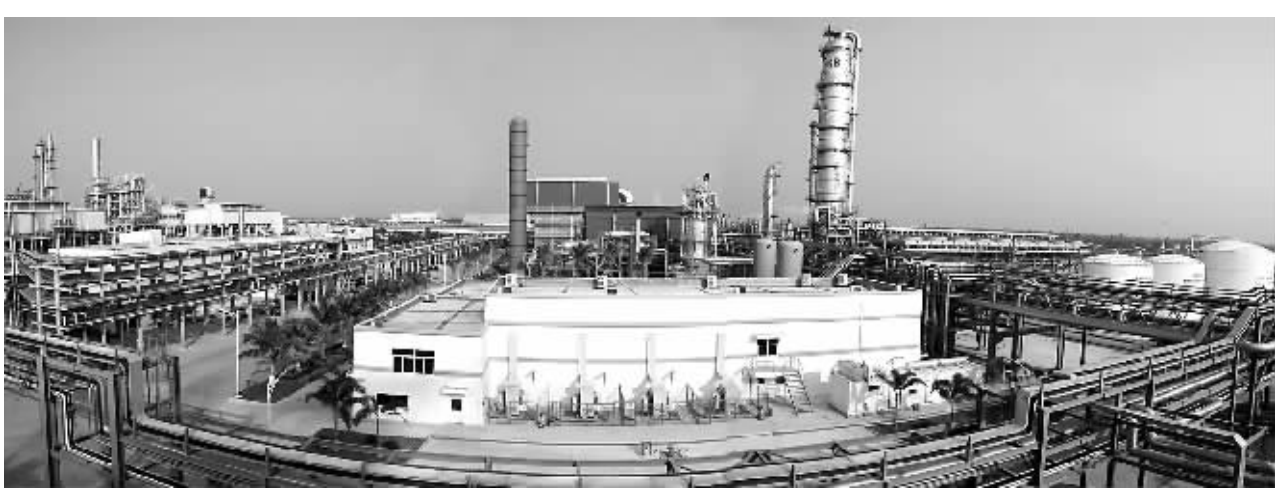
“两大”战略的实施让海南从经济困局中成功突围。图为中海油东方化工一角。 本报记者 王凯 摄
