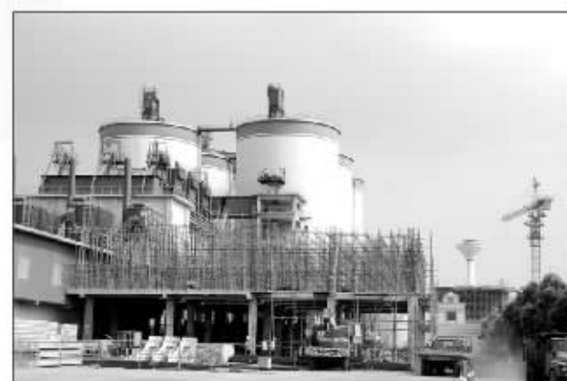
华盛澄迈二期工程
