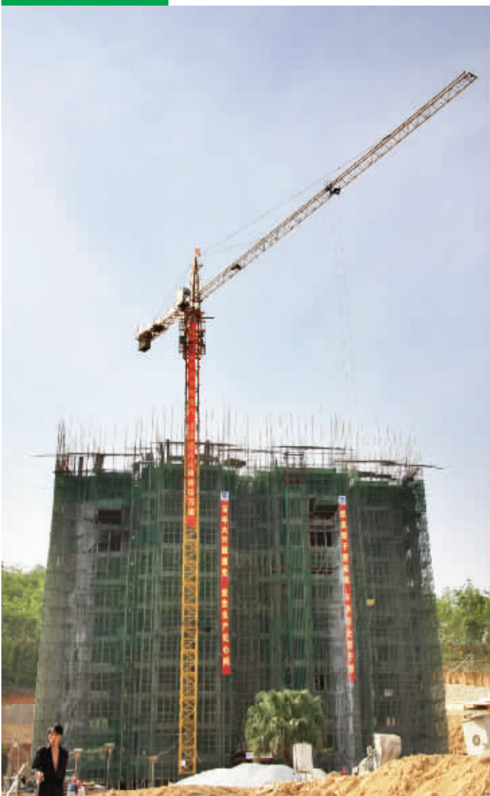
正在建设中的住宅小区湖湖岸边
