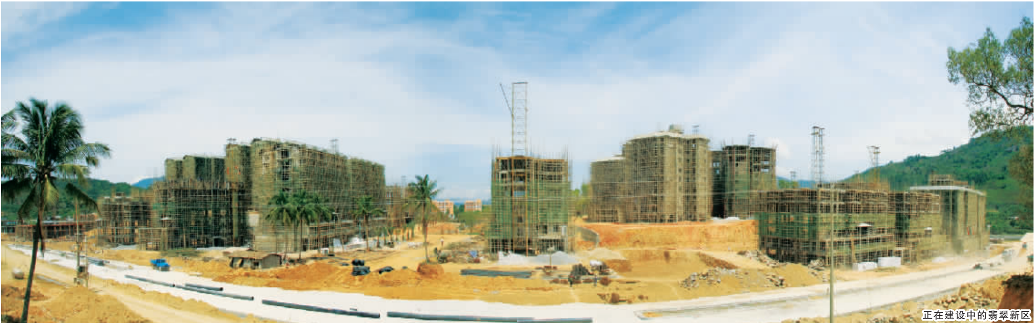
正在建设中的翡翠新区
