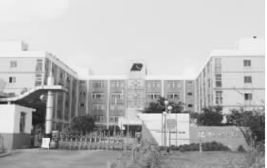
立升科技——世界最大超滤膜生产基地。
