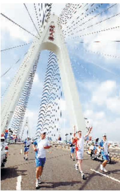
跨越世纪大桥
