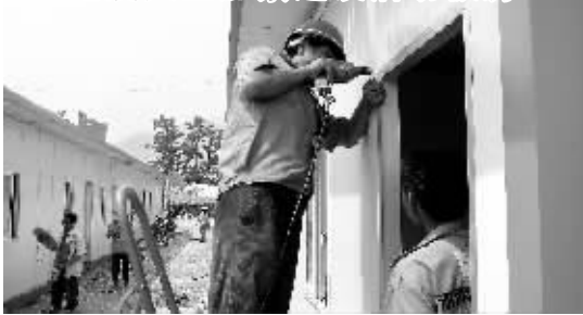
目前四川多数受灾群众只能住在临时搭建的简易帐篷内,为尽快使群众安居,灾区正在加快建设更加实用的活动板房。
