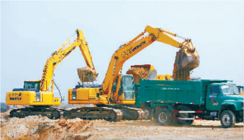
海棠湾路网基础建设工地一片热火朝天。 本报记者 李英挺 摄
