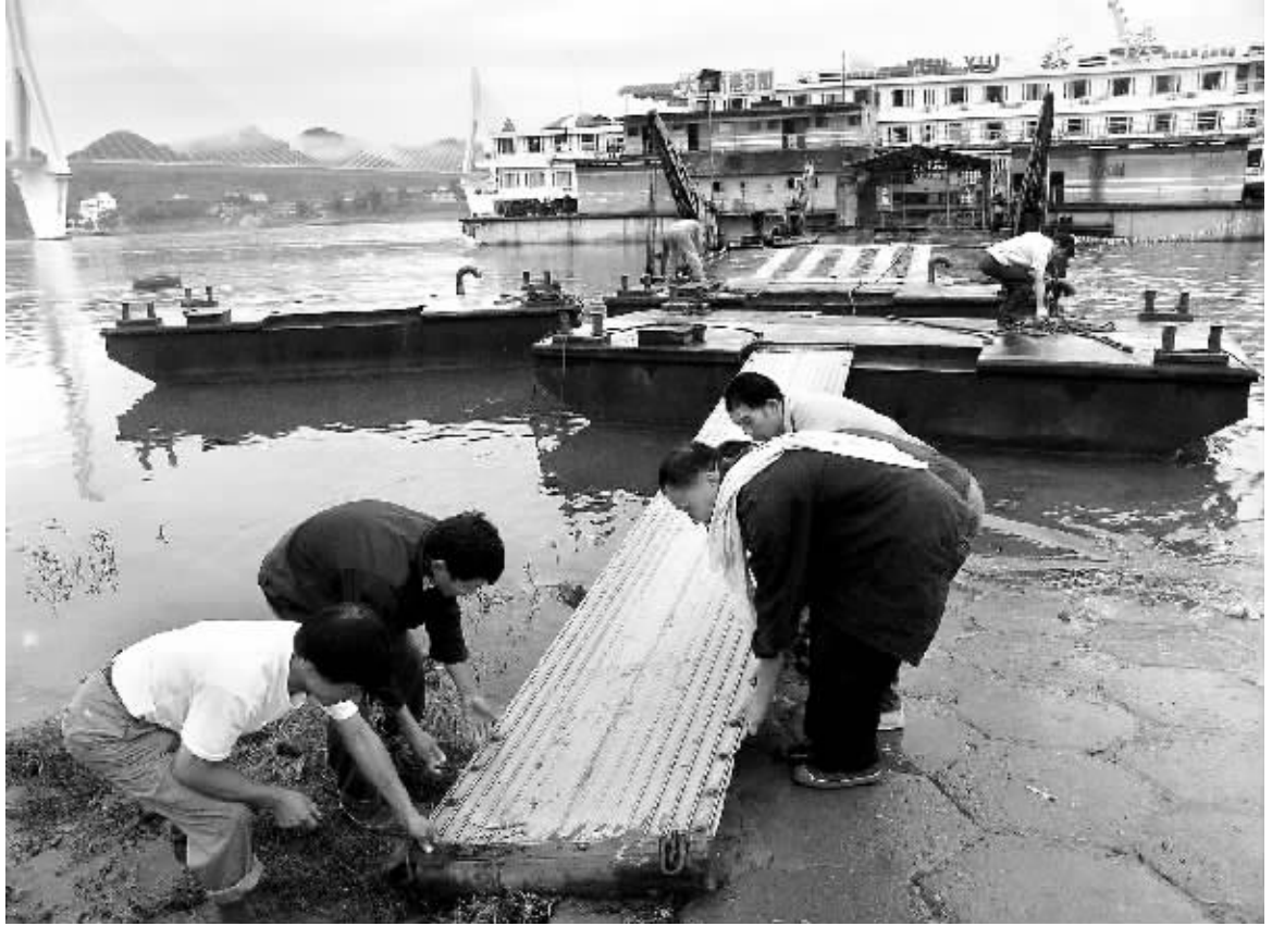
6月9日，工作人员在宜昌大桥桥墩加固踏板。持续降水天气造成长江宜昌段水位攀升，宜昌港务集团加大防汛安全准备工作。
