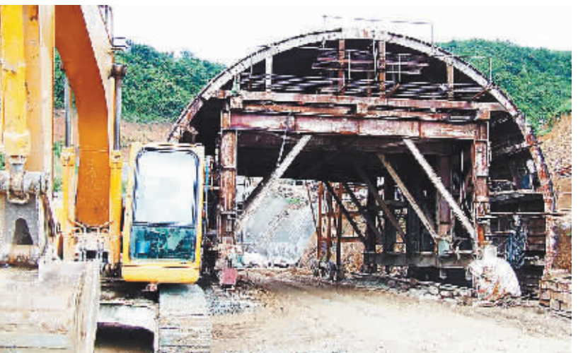
为统筹城乡全面发展,三亚市不断加快当地基础设施建设。总投资19亿多元的三亚绕城高速公路今年3月动工以来进展顺利。截至6月14日,总长565米绕城公路科技园隧道已挖至356米。 本报记者 程范滢 通讯员 贾远平 摄影报道
