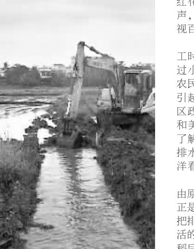
红化田洋排水渠施工现场。
