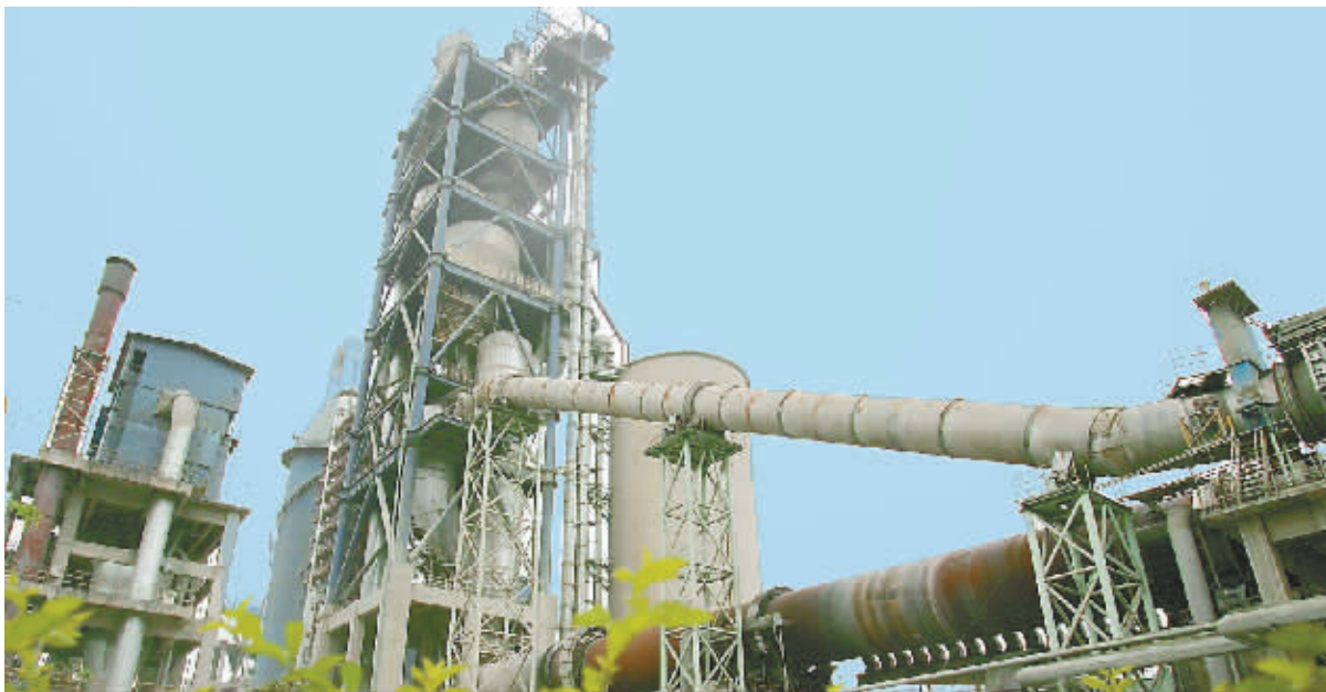
昌江黎族自治县的海岛国投海南水泥有限责任公司建成的余热发电系统,可实现水泥生产线三分之一电力的自给,同时每年可减排4万多吨二氧化碳,经济效益和环保效益显著。
