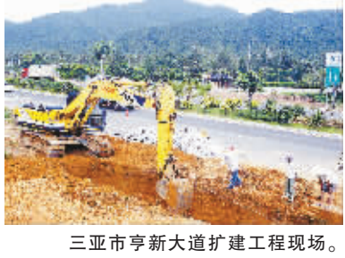
三亚市亨新大道扩建施工现场。
