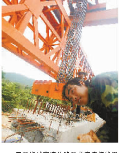
三亚绕城高速公路亚龙湾连接线田独大桥施工现场。本报记者 程范淦 摄
