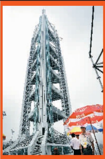
为让各国转播商更好地报道北京奥运会盛况,北京奥组委在国际广播中心(IBC)和“鸟巢”之间搭建了一座七层的多功能演播塔。图为7月28日拍摄的多功能演播塔。
