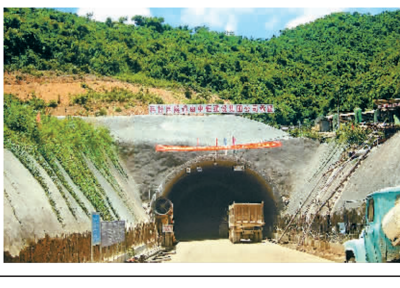
8月16日下午,科技园隧道贯通。 本报记者王勇 摄
