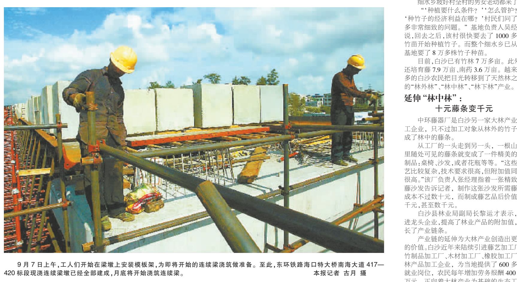
9月7日上午,工人们开始在梁墩上安装模板架,为即将开始的连续梁浇筑做准备。至此,东环铁路海口特大桥南海大道417—420标段现浇连续梁墩已经全部建成,月底将开始浇筑连续梁。
