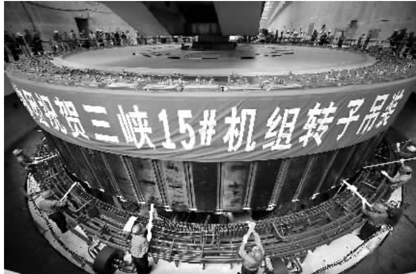
9月8日,建设者在吊装三峡右岸电站最后一台水轮发电机组转子。三峡工程初步设计中全部26台70万千瓦机组已有25台投产,其中左岸电站14台机组于2005年9月全部投产,右岸电站已有11台投入发电。三峡右岸最后一台机组目前正在加紧安装,预计10月底11月初可并网发电。 新华社记者 郝同前摄
