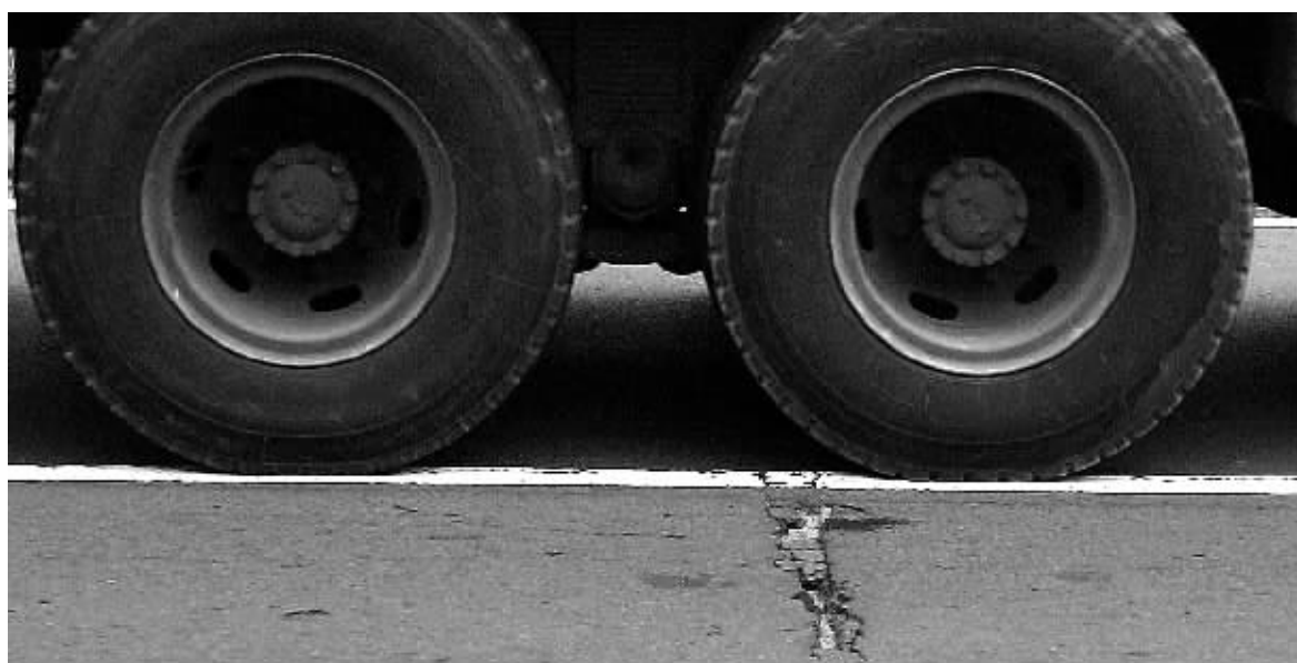
超载货车压坏道路。(资料图片)
