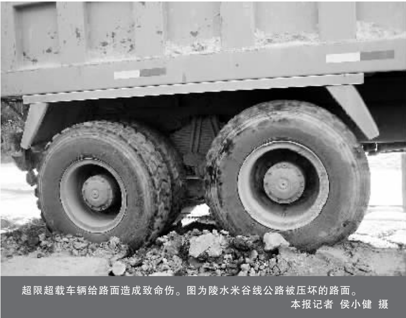
超限超载车辆给路面造成致命伤。图为陵水米谷线公路被压坏的路面。
