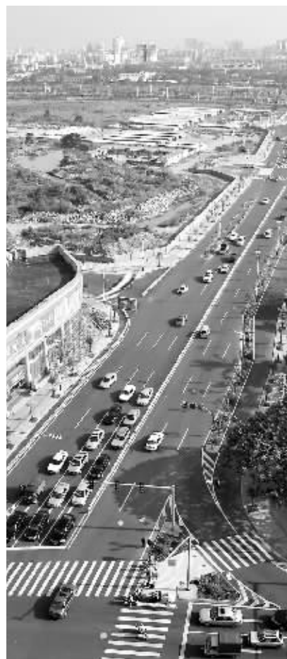
已经修建好的五指山南路,连接五指山路和国兴大道。 本报记者 王凯 摄
