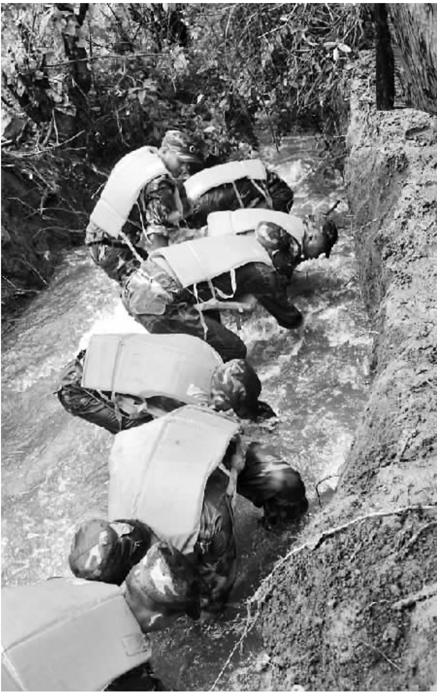
某部官兵在为琼山区美食水库开挖导流渠。 侯坤 摄
