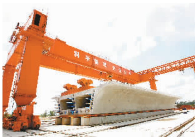
↑继9月27日东环铁路架铺箱梁的关键设备之首台900吨轮轨式提梁机在中铁四局海南东环项目部琼海制梁场安装调试完成后,工作人员马上投入运梁车和架梁机安装工作。目前已完成拼装,进入最后调试运行阶段。
