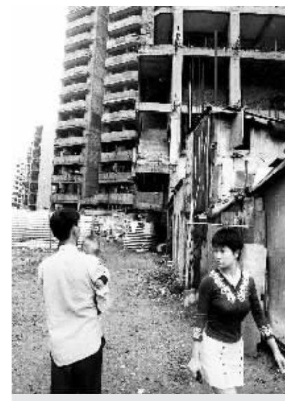
海口曾经的“烂尾楼”
