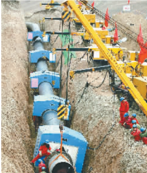
西气东输二线工程的建设者在新疆伊犁哈萨克自治州霍城县境内施工。 新华社发
