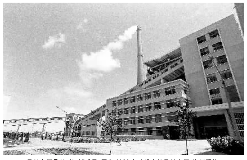
马村电厂是“打基础”成果，图为1989年建设中的马村电厂(资料照片)。 本报记者 武进群 摄
