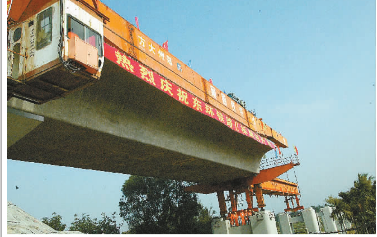
12月7日，重达700吨的首个箱梁被成功安装在东环铁路文峰特大桥桥台上。
