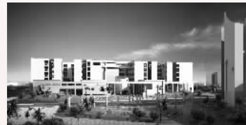
在建的第四教学楼
