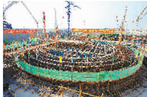
第一罐混凝土浇筑阳江核电站1号机组工地。
