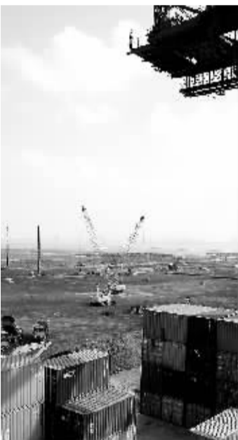
未来五年,我省围填海建设项目会越来越多,但不会出现无法控制的局面。图为海口市秀英港围填海工地现场。
