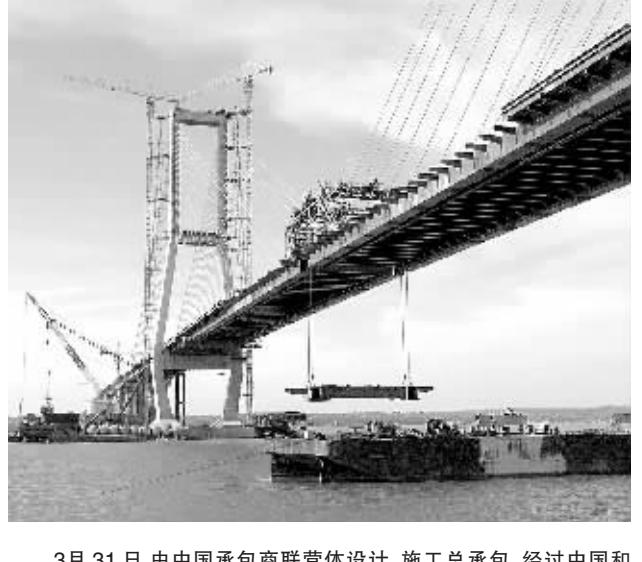
3月31日,由中国承包商联营体设计、施工总承包,经过中国和印尼承建商3年多的合作,东南亚最大的跨海大桥——印度尼西亚泗水—马都拉大桥(泗马大桥)合龙。泗马大桥坐落在印度尼西亚爪哇岛,是连接印尼第二大城市泗水和经济基础薄弱的马都拉岛的第一座跨海大桥,总长5438米,由主跨434米的斜拉桥、引桥和堤岸桥组成,其中主桥长818米,引桥长1344米,桥宽30米。新华社发
