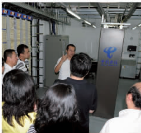
中央媒体记者在博鳌机房采访通信保障情况
