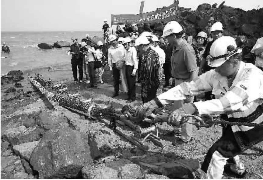
3月17日,海南跨海联网工程首根海底电缆在澄迈县桥头镇林诗岛顺利上岸。
