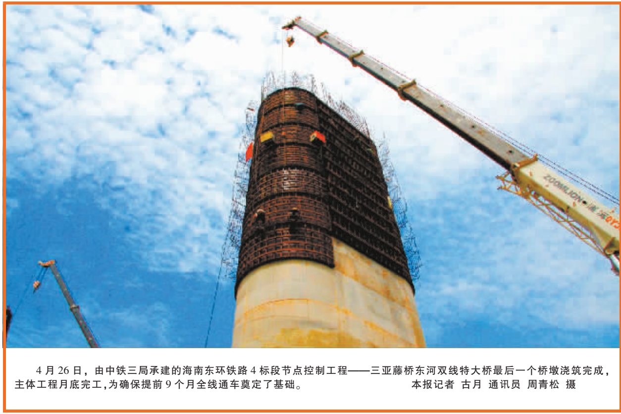
4月26日,由中铁三局承建的海南东环铁路4标段节点控制工程——三亚藤桥东河双线特大桥最后一个桥墩浇筑完成,主体工程月底完工,为确保提前9个月全线通车奠定了基础。
