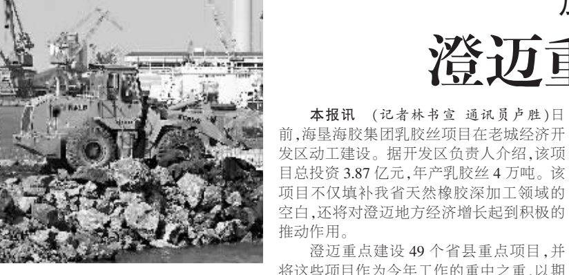
马村港扩建工程加紧施工
