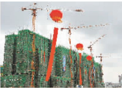
5月15日，建设中的金玉广场。
