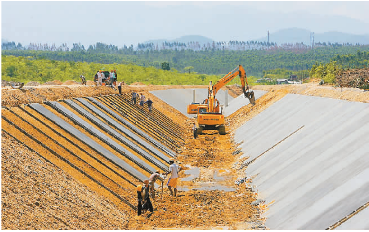
大广坝二期加紧施工
