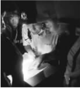
6月4日，三亚迎宾隧道发生塌方后第一时间，有关人员现场讨论救援决策。 海南日报记者 程范淦 摄
