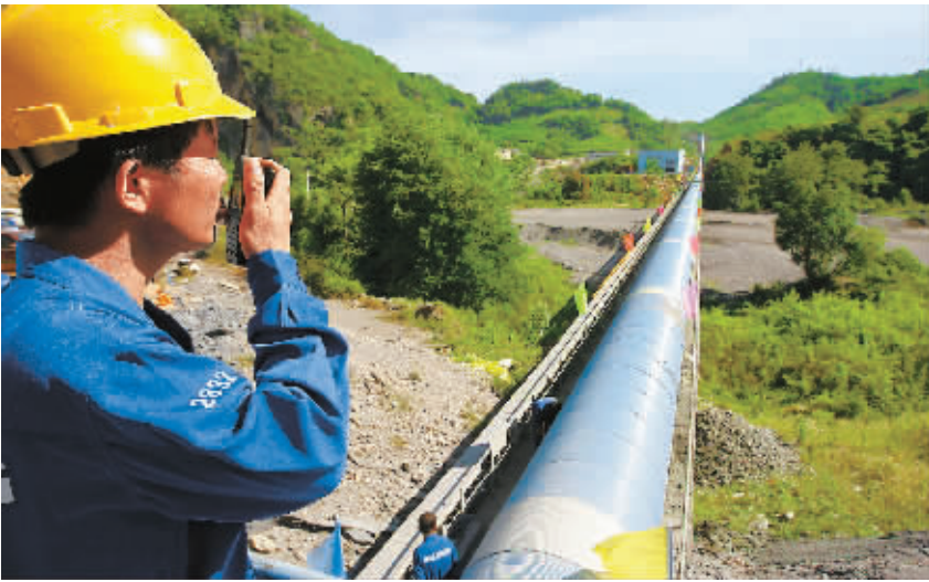
7月2日,工人正在观察石灰石胶带的运行情况。
