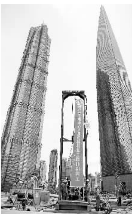
中国第一高楼 上海中心主楼桩基工程竣工
